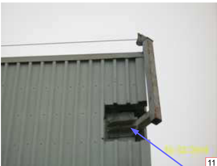
PROBABILE ACCESSO INFILTRAZIONE ACQUA PIOVANA
