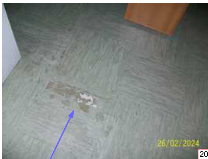
PAVIMENTAZIONE DANNEGGIATA
