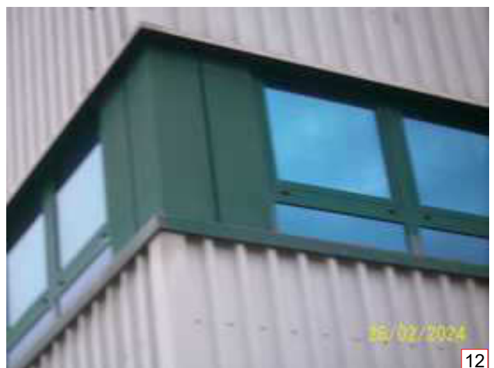
PROBABILE ACCESSO INFILTRAZIONE ACQUA PIOVANA
